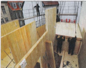
Fertig geschnitten kamen die Teile für das Wohnhaus am Fischersand 41 an. Foto: Hartmut Schwarz
